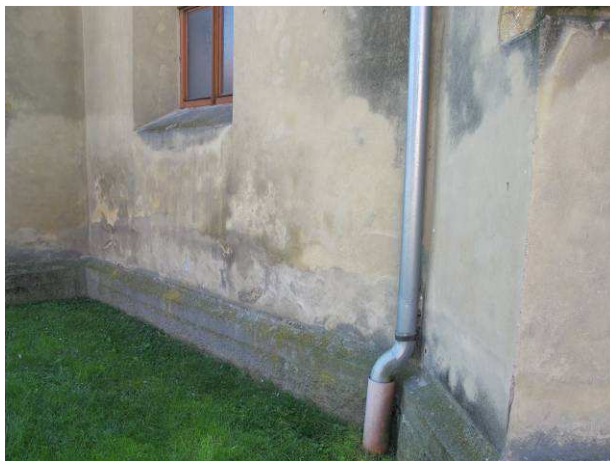
Foto č.6 – vlhkostní mapy a začínající degradace omítek nad soklovou částí
