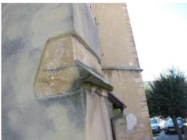
Foto č.9 – pískovcový okenníkový prvek na zpevňujícím žebru fasády
