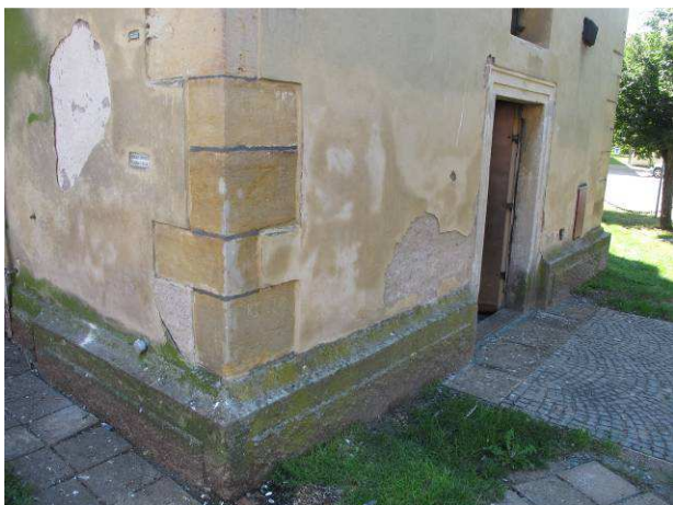
Foto č.7 – úprava soklu cementovou, paroneprodyšnou, omítkou, která je přetažena i na pískovcový profil
