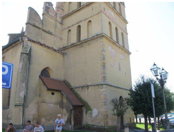
Foto č.2 – lokální poškození omítek v ploše fasády od povětrnostních vlivů s množstvím říms, stříšek a ploch opěrných sloupů, z kterých stéká srážková voda
