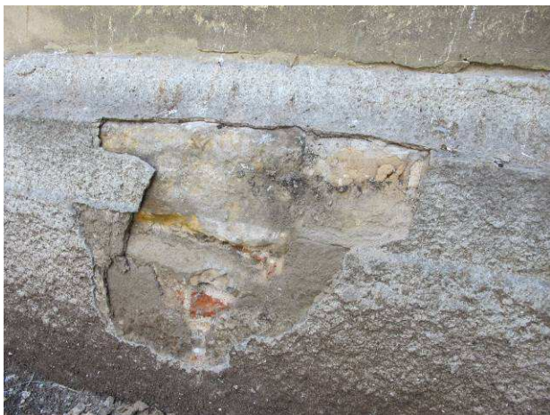
Foto č.13 – sonda provedená v soklu fasády; předsazená profilace je tvořena pískovcovým blokem, pod kterým se nachází cihelné, případně kamenné zdivo
