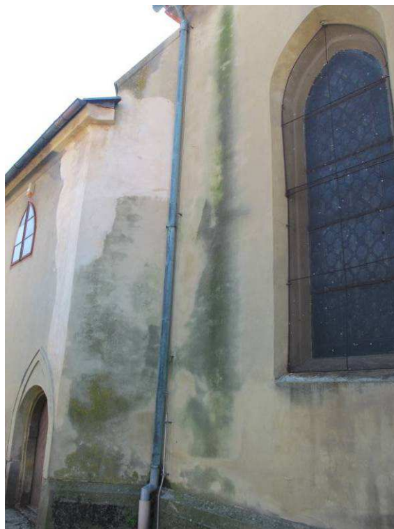
Foto č.4 – biotetické napadení na fasádě v místě nekontrolovatelného stékání srážkové vody
