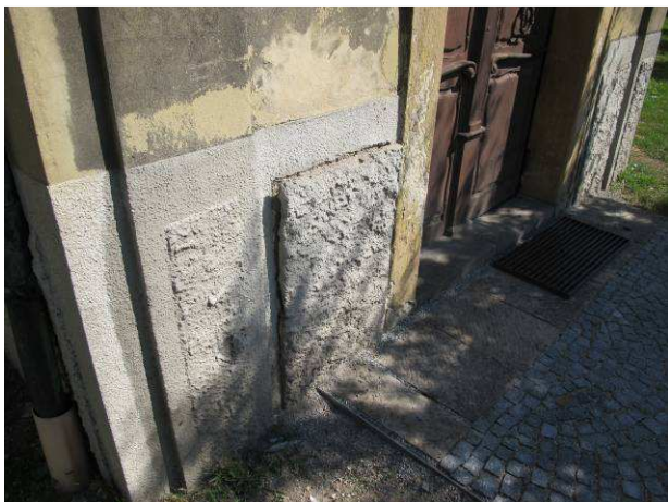
Foto č.11 – novodobá cementová úprava soklové části bočního vstupu s odtrženou profilací
