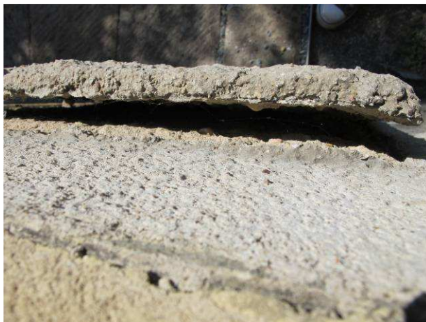
Foto č.12 – detail odtržené profilace soklu
