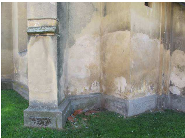
Foto č.5 – povrchové a hloubkové degradace omítek od působení vlhkostní zátěže a vysolovacích procesů, včetně mrazových cyklů
