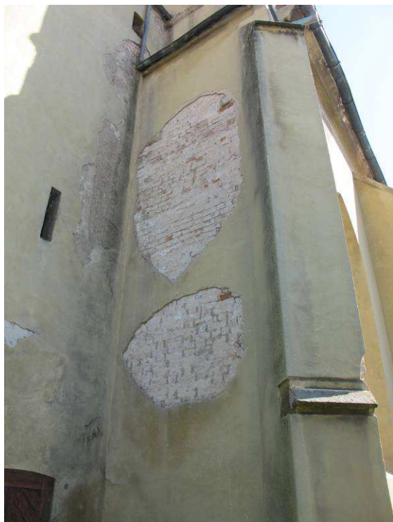
Foto č.3 – zcela opadané omítky v ploše fasády
